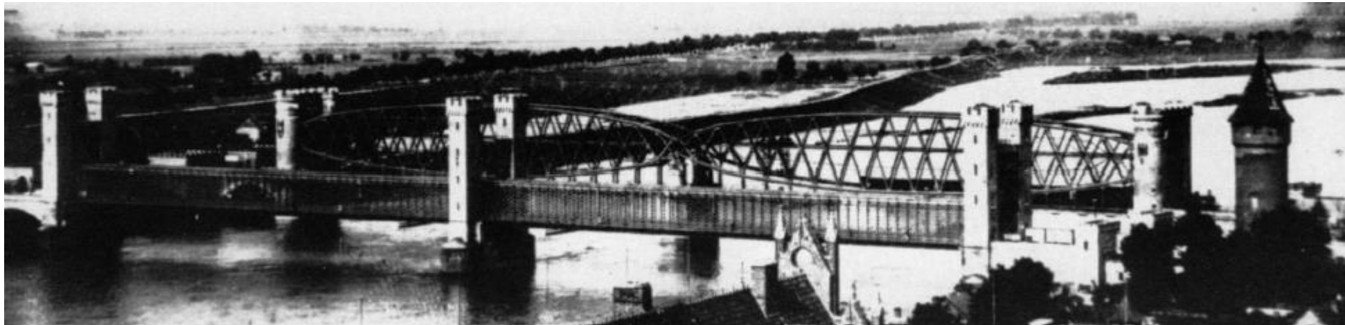
Abbildung 2: Sascha Steffen, Historie der Ril 805 „Tragsicherheit bestehender Eisenbahnbrücken“, Stahlbau Volume90, Issue2, February 2021
